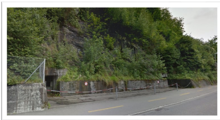
Abbildung 10: Überkragende SW bei Gebäuden und befestigten Flächen (Foto Situation vor Ort)
